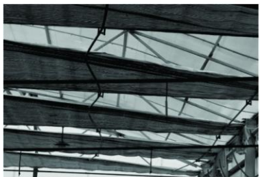
图4 内保温遮荫机构故障
