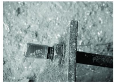
图6 锚栓螺纹保护
