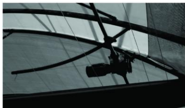
图1 开窗电机驱动传动机构
