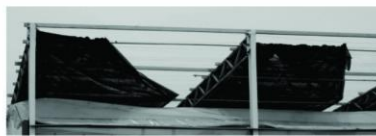
图5 外遮阳机构故障
