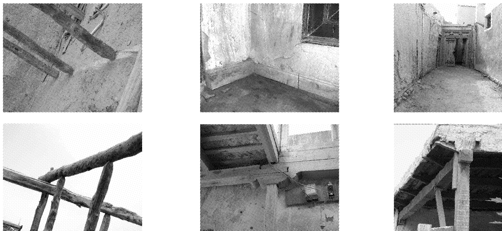
图3 防潮、稳固的木结构使用方式
