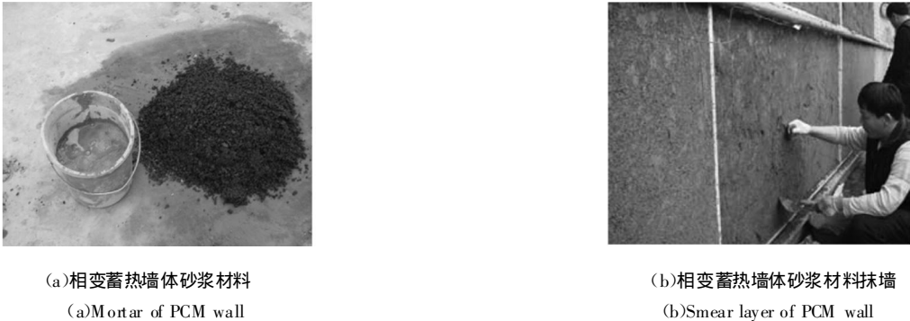
图3 相变蓄热墙体材料及施工
